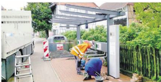
Montage der Fahrradständer in Reiffenhausen.
